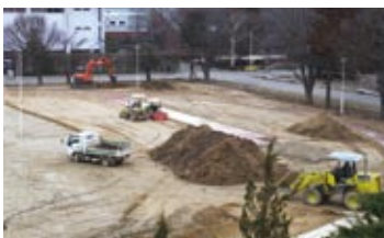
除線作業 表土交換
