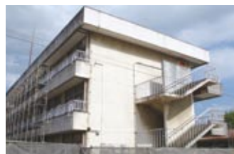
実験棟 取り壊し前
