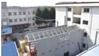
2018.3.13渡り廊下撤去①
