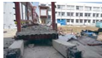
渡り廊下撤去③
