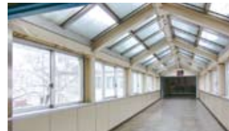
本館から3号館への渡り廊下
