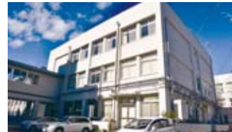
3号館南(保健室)側
