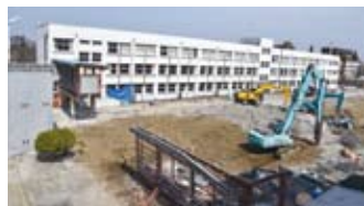
渡り廊下撤去②
