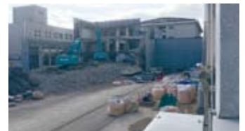
3号館解体工事2018.2.22
