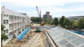
基礎工事②
