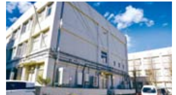
解体前の3号館東側
