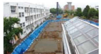
基礎工事2018.7.6現在
