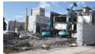
3号館解体工事2018.2.20
