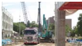
基礎工事③
