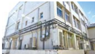
解体前の3号館(北側警備員室入り口)
