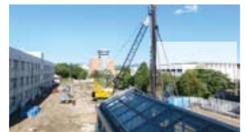
基礎工事①
