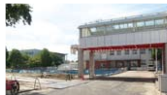
基礎工事④
