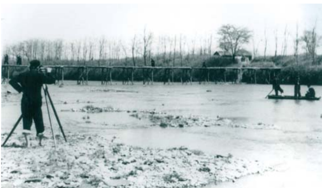
ガンタラ橋 永盛方面に向かって測量する土木科生徒
