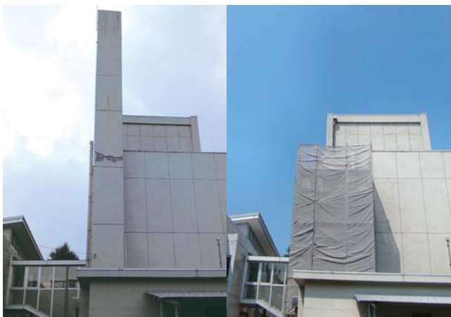
震災直後の一号館（煙突にひび） 煙突切除後の一号館（7月15日現在）
